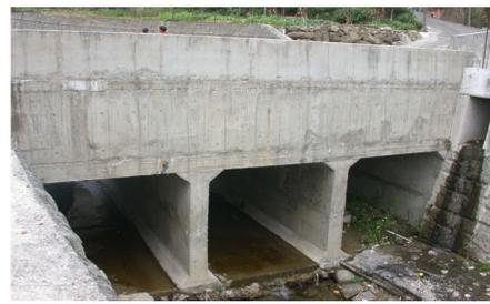
圖5 富國橋通水斷面較小，易遭土石阻塞，造成溢流淹沒道路
