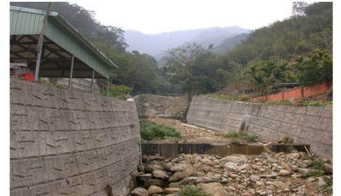
圖4 下游護岸工程與固床工
