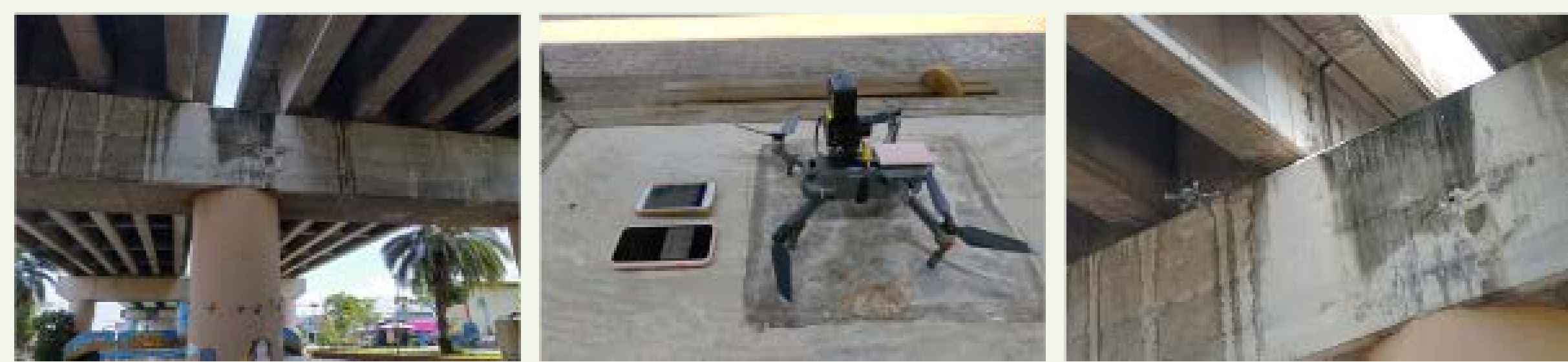
拍攝橋梁現場圖
