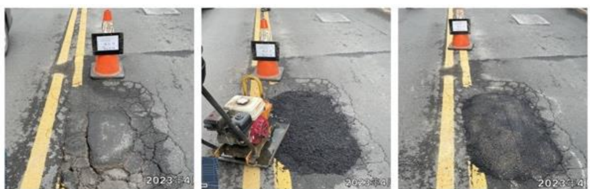
圖4 緊急坑洞修補實例
