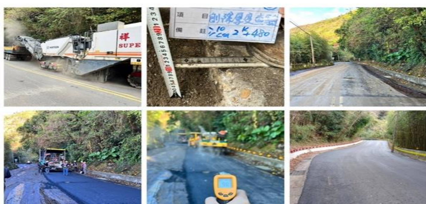
圖2 全路幅剷除加鋪實例
