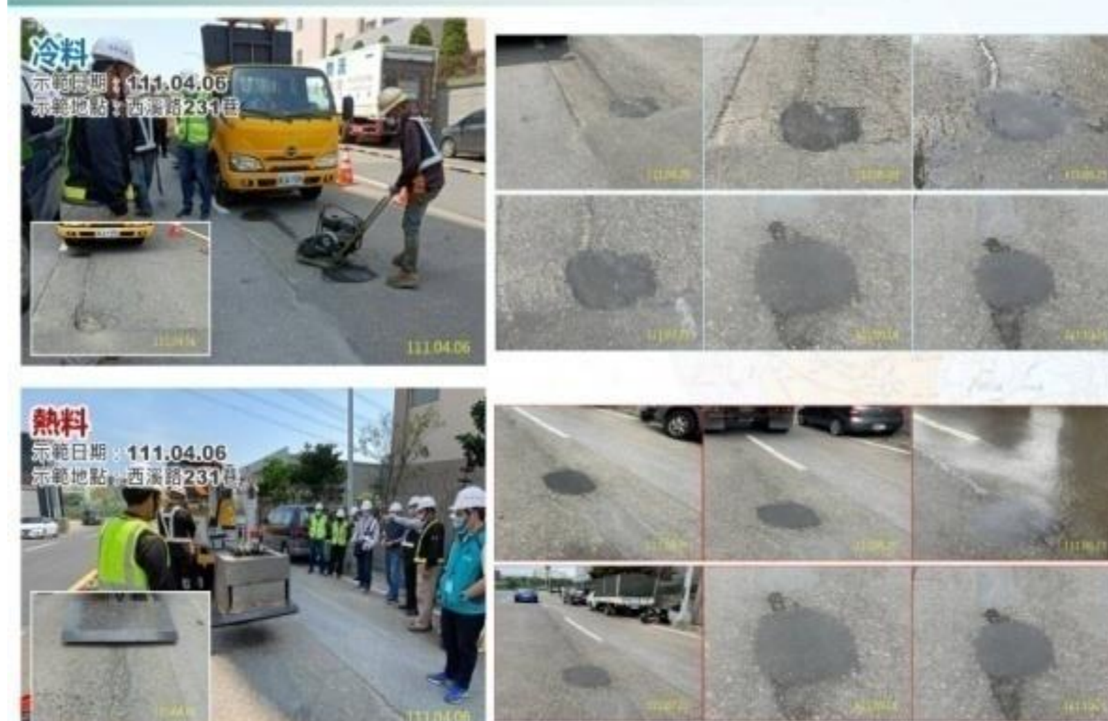
圖10 傳統式坑洞修補方式比較
