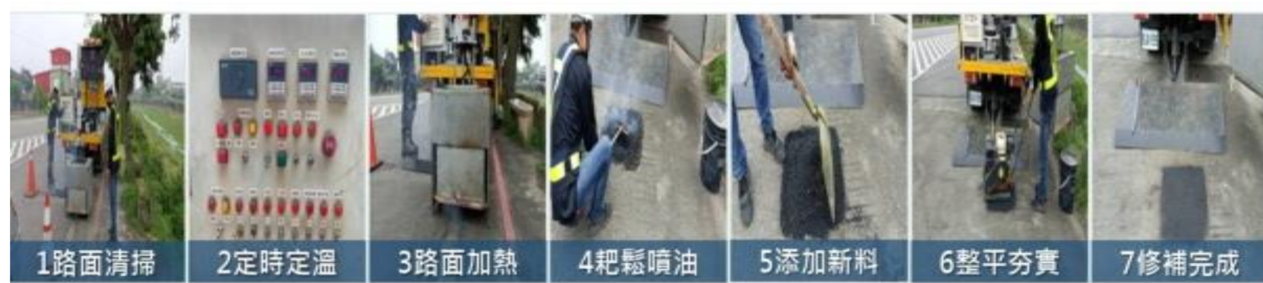
圖9 加熱型鋪面維護車施工工程
